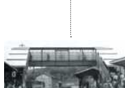
4月23日に架設した陸橋
