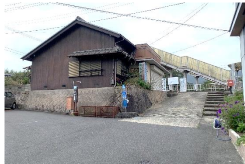
[月ヶ瀬口駅(駅前施設)]
