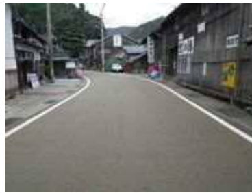
町道日出平田線 景観舗装・側溝改良
