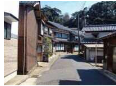
府道伊根港線 景観舗装・側溝改良予定
