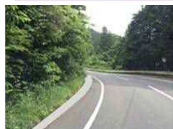
府道綾部大江宮津線側溝蓋設置予定
