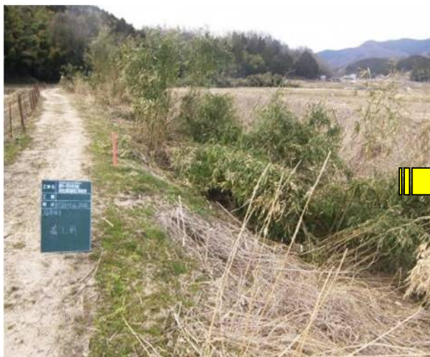
樹木が河川を阻害しており危険
