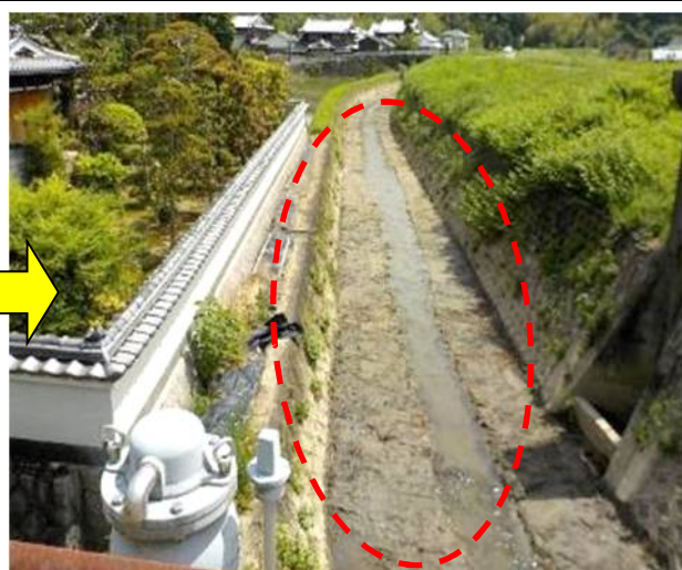
土砂を撤去して河川の流れを確保！
