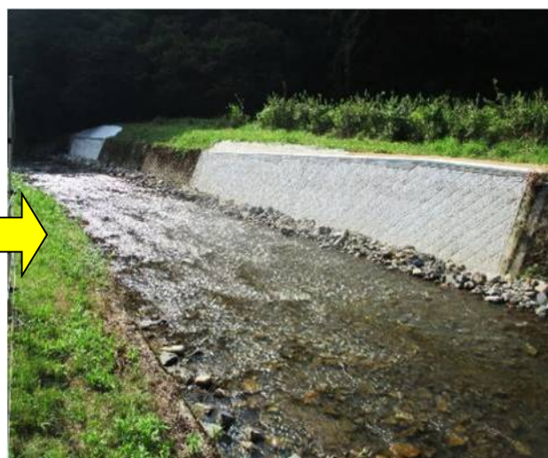
コンクリートブロックで改良！
