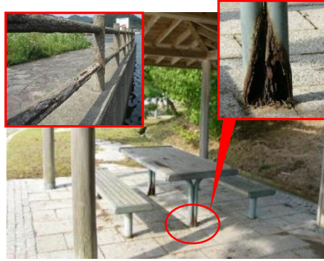
□施設が壊れている
