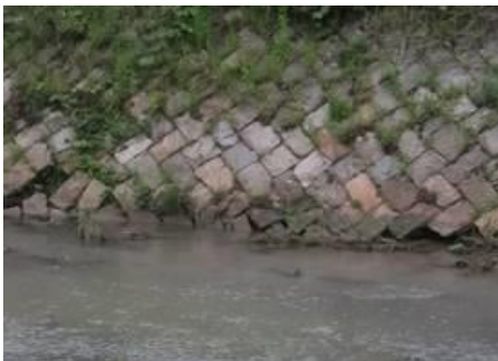
□護岸が崩れかけている
