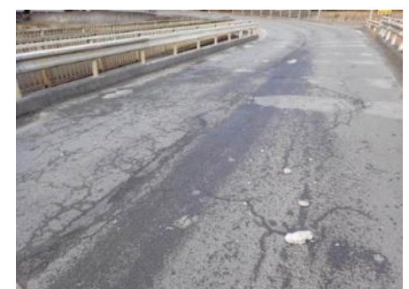
□ 舗装がひび割れしている
