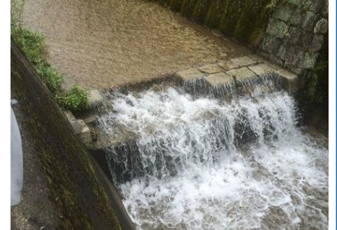
□構造物が一部壊れている
