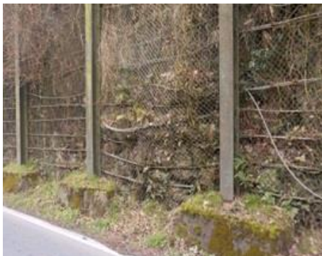
□落石を止める網や柵が壊れている
