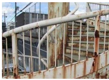
□ 歩道橋が錆びている
