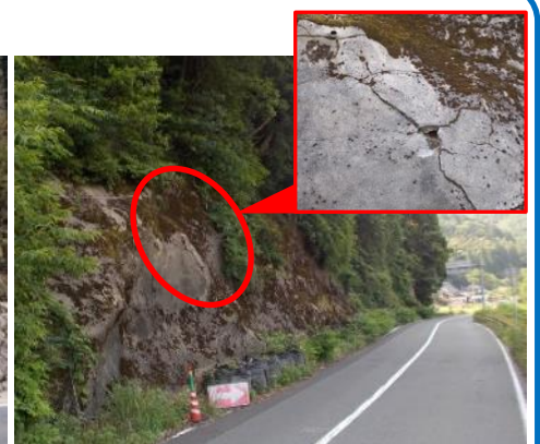
□のり面にひび割れがある
