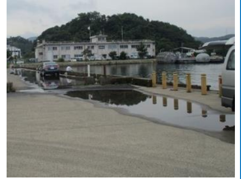
□舗装が沈んでいる
