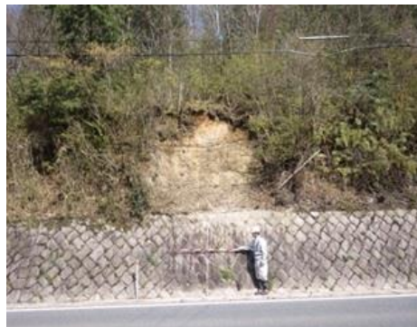
□のり面が崩れている
