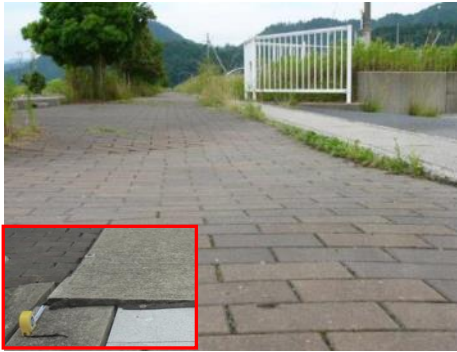
□歩道舗装が沈んでいる
