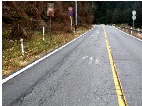
□舗装が波打っている
