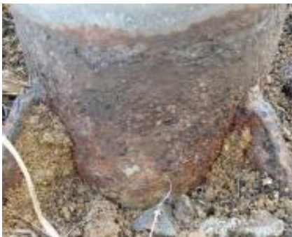
□標識柱の根元が錆びている
