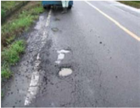
□舗装の一部に穴が開いている
