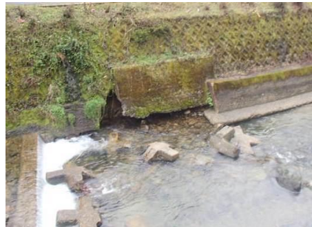
□護岸が崩れかけている
