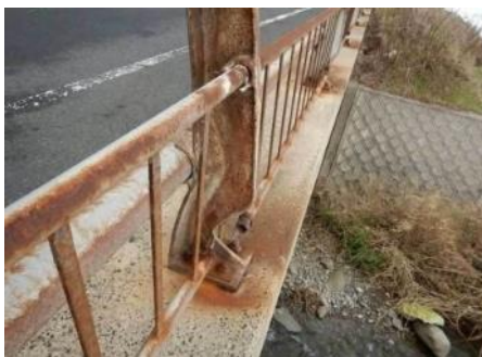
□ 柵が錆びている
