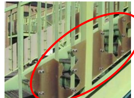
□ 歩道橋のパネルが壊れている
