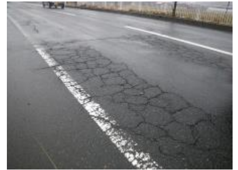
□舗装がひび割れしている
