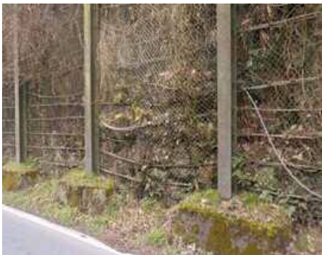
□ 落石を止める網や柵が壊れている
