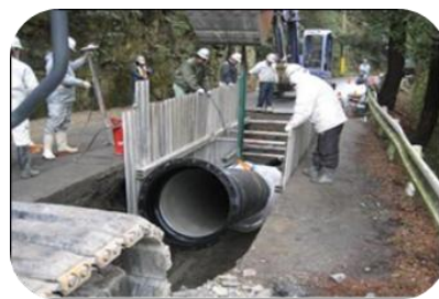
<管の布設工事>
