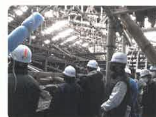
寺社修復現場実習
