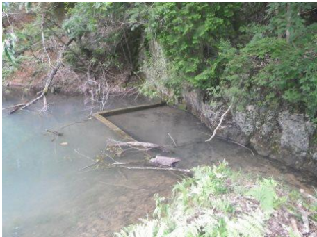
奥池 洪水吐の現状
