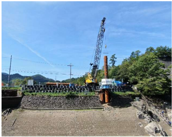
堤体を鋼管杭で補強します
