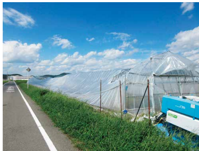
台風21号の暴風で歪んだハウス（亀岡市、平成30年9月）
