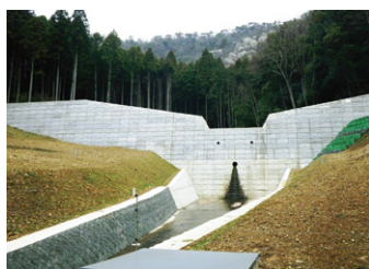
砂防設備の整備
