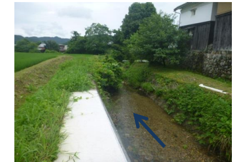
25災の復旧完了
