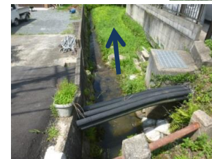
市道橋直下流 取水
