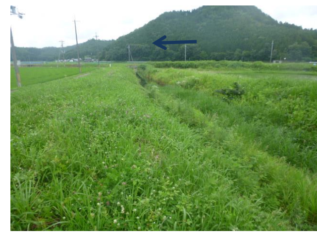
堤内地から本梅川左岸堤防を望む
