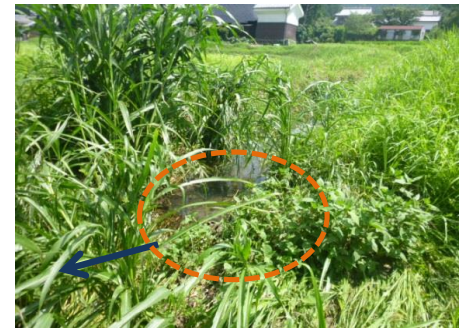
土砂堆積状況
