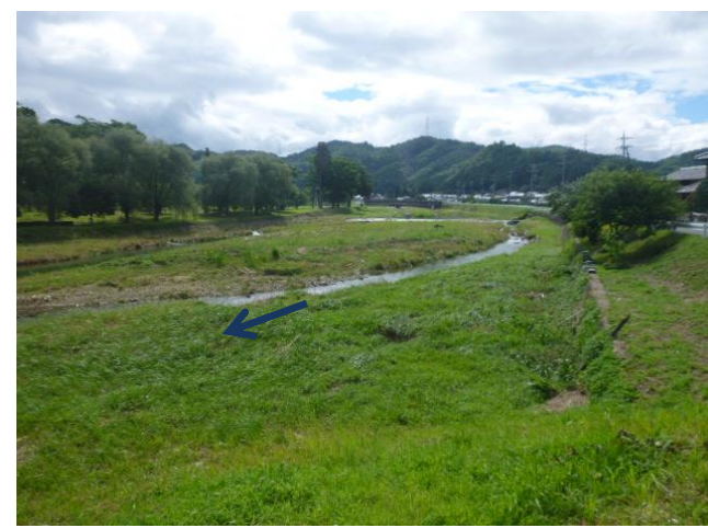
土砂堆積あり
