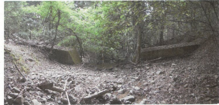
① 平成9年度施工治山ダム工上流の堆砂状況
