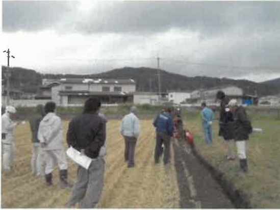
額縁明渠設置作業
