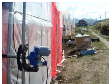
巻き上げ機(左手前)を設置
