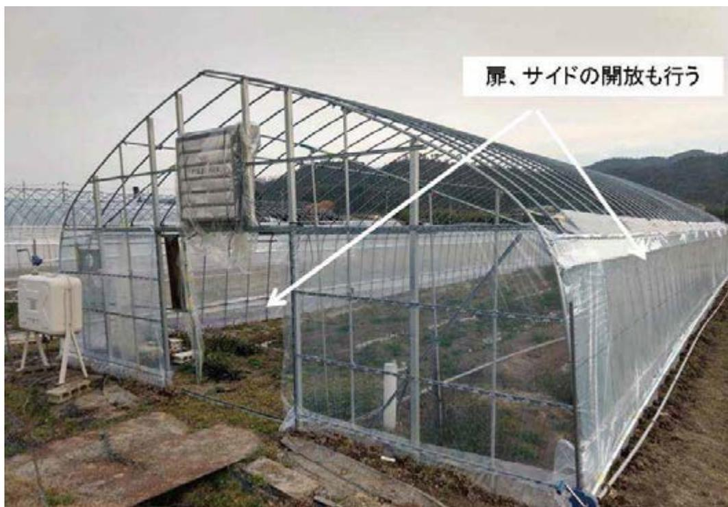
※妻面が風を受けて奥行方向へ倒壊する場合がありますので、方杖パイプ等で補強する。
