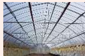
タイバーによる補強
