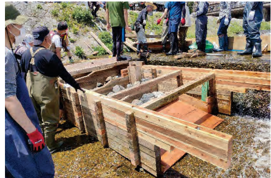
河川への簡易魚道設置の様子
