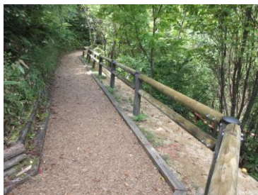
木製安全柵、ウッドチップ舗装
