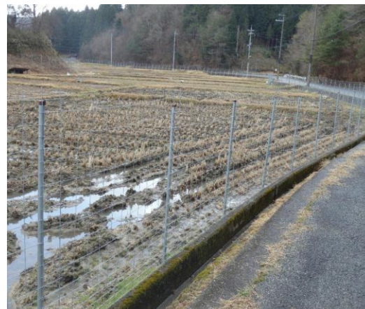
防護柵の設置
