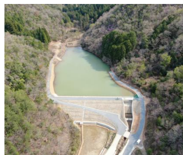
改修済ため池
