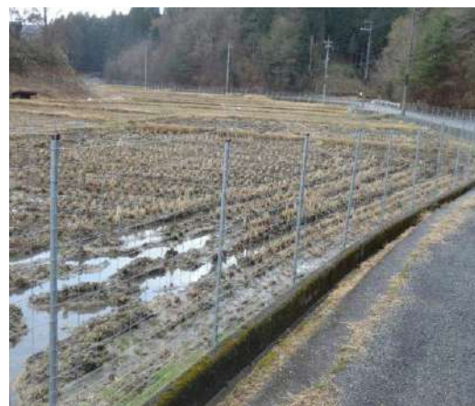
防護柵の設置
