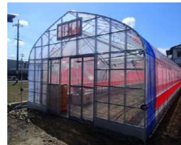
導入を推進するパイプハウス
