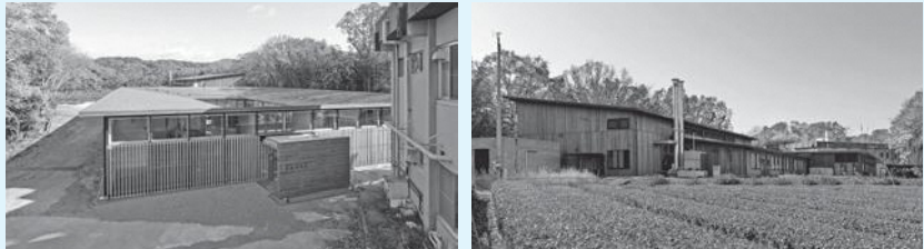
新しい本館の外観（左）、製茶研究棟の外観（右） <オール府内産木材による木造建築、一部に CLT（直交集成板）を使用>
