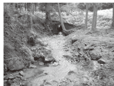
事業実施後の状況 (倒木等を整理)
