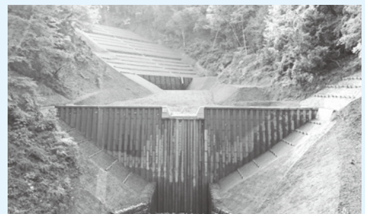
完成した治山施設（治山ダム工と山腹工）
