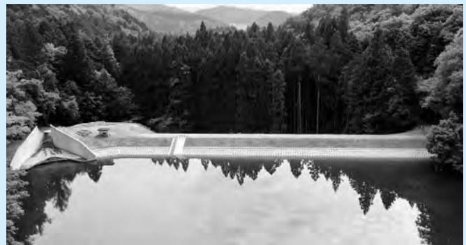
改修後の大保池
