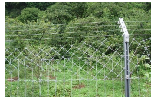
端材の有効利用 (スキ間を端材で補強)
