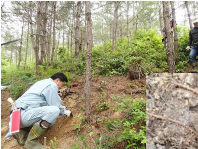
地表の被覆処理作業：赤土を露出させシートで被覆する。
