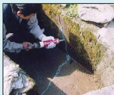
ひび割れの補修
