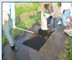
農道の部分補修
