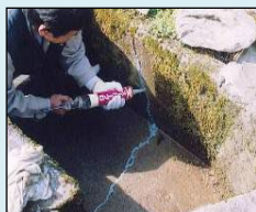
ひび割れの補修
