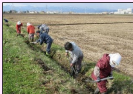
水路の泥上げ
