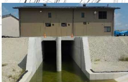
排水機場 【施工状況(R7.8)】
