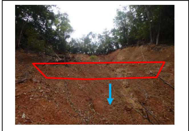
崩壊斜面状況 (土留工設置位置)
