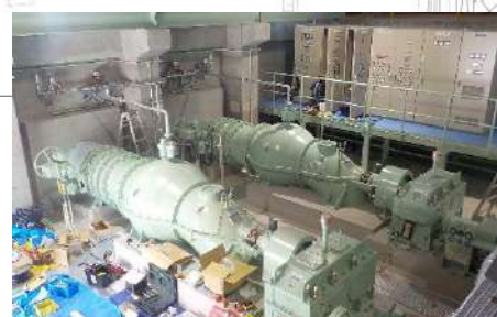
排水ポンプ 【施工状況(R8.5)】
