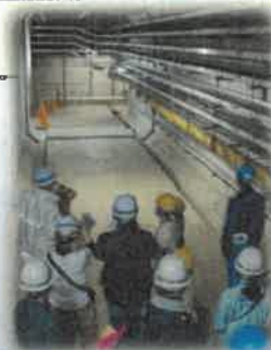
地下通路 『管廊』
