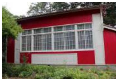
修繕工事が完了した「山のアトリエ」
