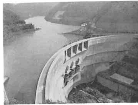
府宮山城水道(左) (昭39・12竣工)は 天ガ瀬ダム(右) (昭39・12完工)から 引水し 宇治市ほか 3 町に給水する
