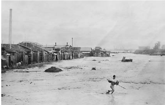
エ 御室川筋右京区山ノ内嵐電軌道南方氾濫状況
