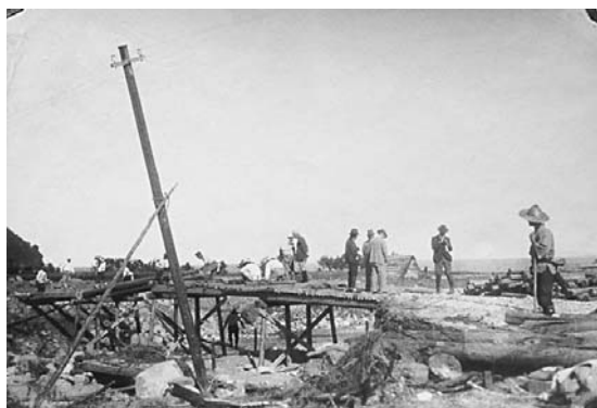
ア 与謝郡内での木橋の崩壊
