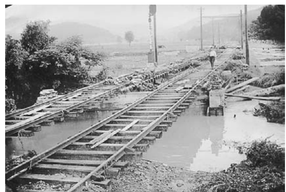
ウ 鞍馬電鉄岩倉駅西側鉄橋付近
