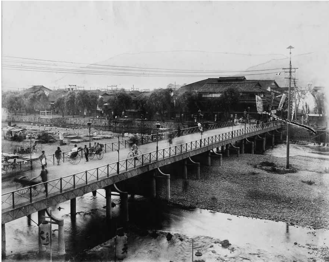
▲四条大橋3 「矢野家写真資料」から
