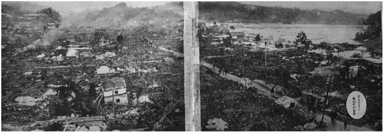
▲北丹後地震後の峰山町の全景（『丹後大震火災』より）
