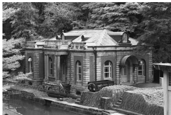
九条山ポンプ室（土橋誠氏撮影）
