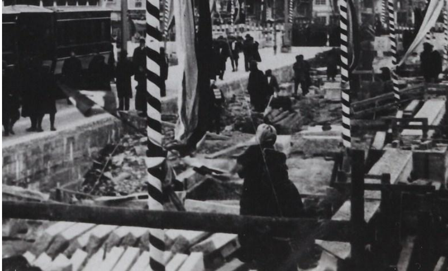
※建設資材が積まれ、高欄の姿も無い建設途上の四条大橋
