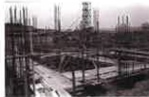
【総合資料館旧館建築】昭和 37 年 2 月 2 日撮影
