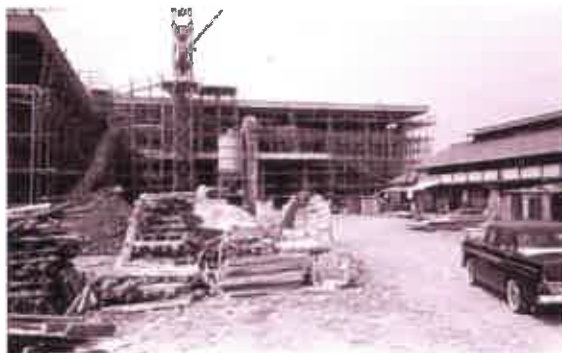
【11月の開館に向けて着々と工事が進む】
