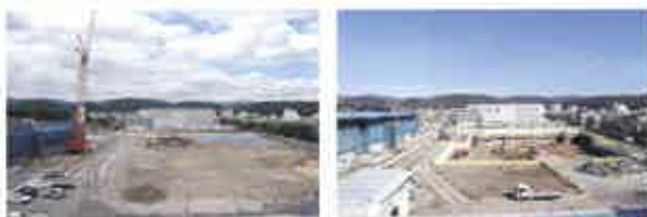
【本工事が進む様子 平成25年10月(左)と平成26年3月】
