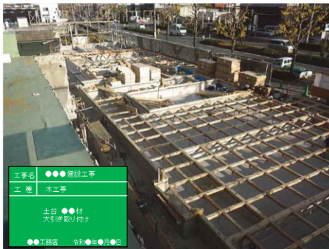
※施工中の写真(引き)
