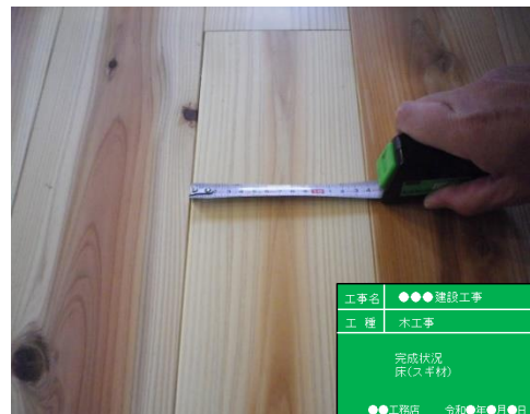
※完成状況の写真(寄り)
