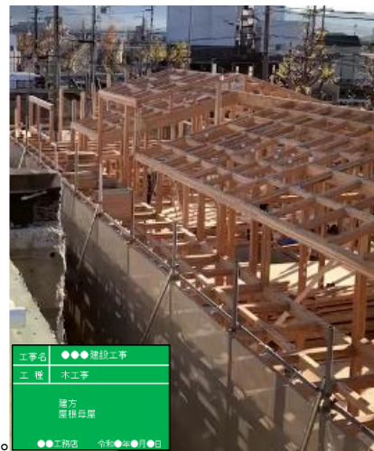
※施工中の写真(引き)
