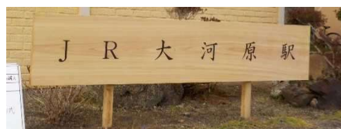
木製看板の設置 公共施設 (南山城村)
