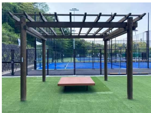
木製パーゴラの設置 公園 (京田辺市)
