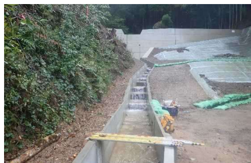
治山施設の流末水路の整備 (舞鶴市)
