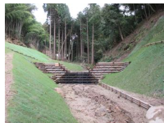
<木製治山ダム>
