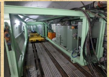
レールを利用して後方台車を移動し、トンネル内に設置しています。
