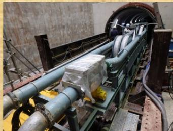
南幹線トンネル内に施工したレールを利用して後方台車をトンネル内で移動しています。
