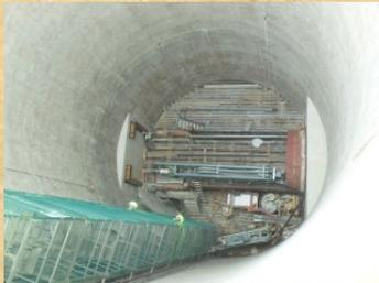
発進立坑から後方台車を南幹線トンネル内に搬入します。
