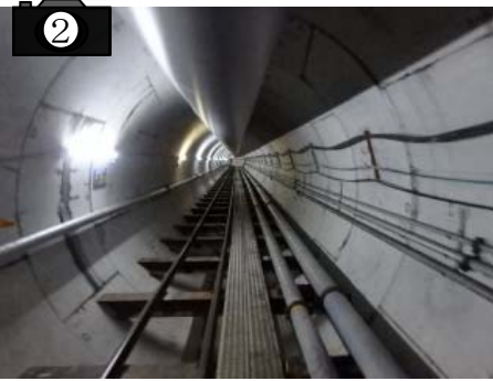
トンネル内部の状況
