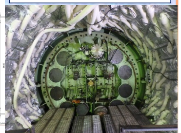
シールドマシン内 (凍結管設置後)
