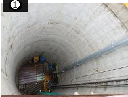
発進立坑内 (坑口) の状況
