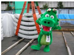
発進立坑 (京都府洛西浄化センター内)
