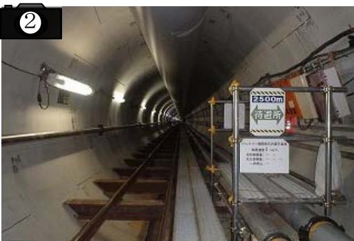
トンネル内部の状況
