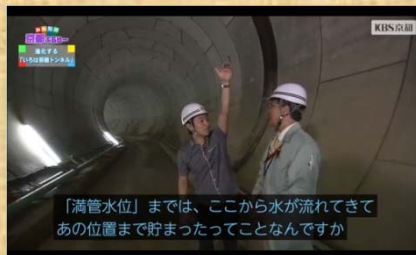
みんなの京都ふらり～ (乙訓ポンプ場)
