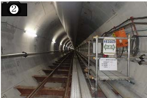
トンネル内部の状況
