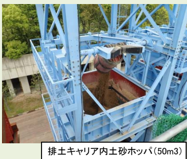
掘削土搬出状況
